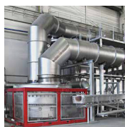
EcoReg® Drehbett-Regenerator
